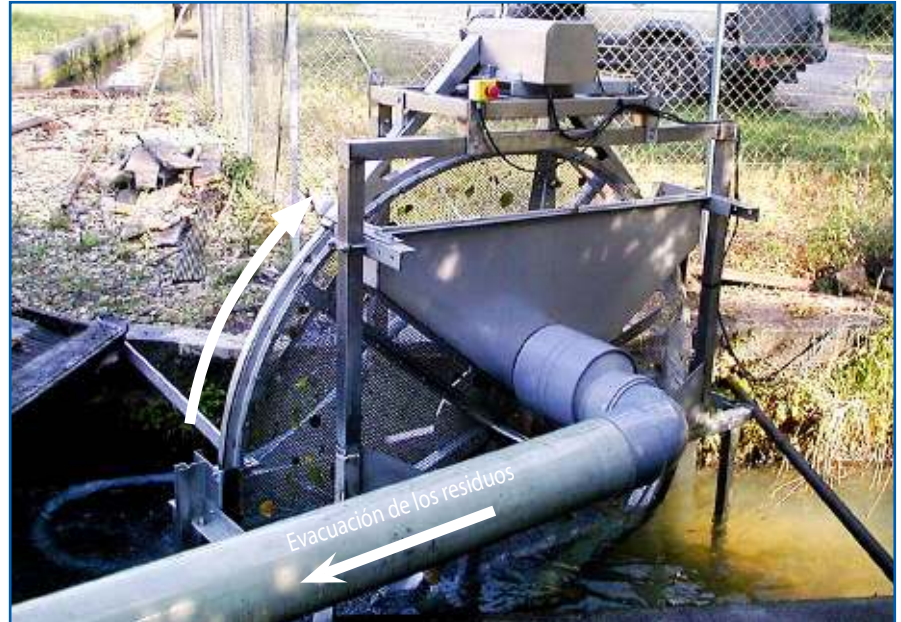
DEBASTADORES Ø2200 - Vista por el costado de llegada del agua
