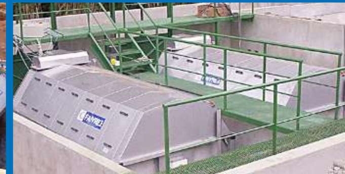
2 Filter 28-160 auf Gestell am Auslauf einer Fischzucht
