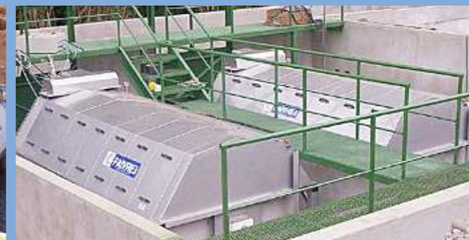
2 filtros 28-160 en armazón en una salida de piscicultura.
