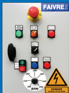
Coffret électrique central équipé d'un convertisseur de fréquence pour contrôler la vitesse de la pompe.
